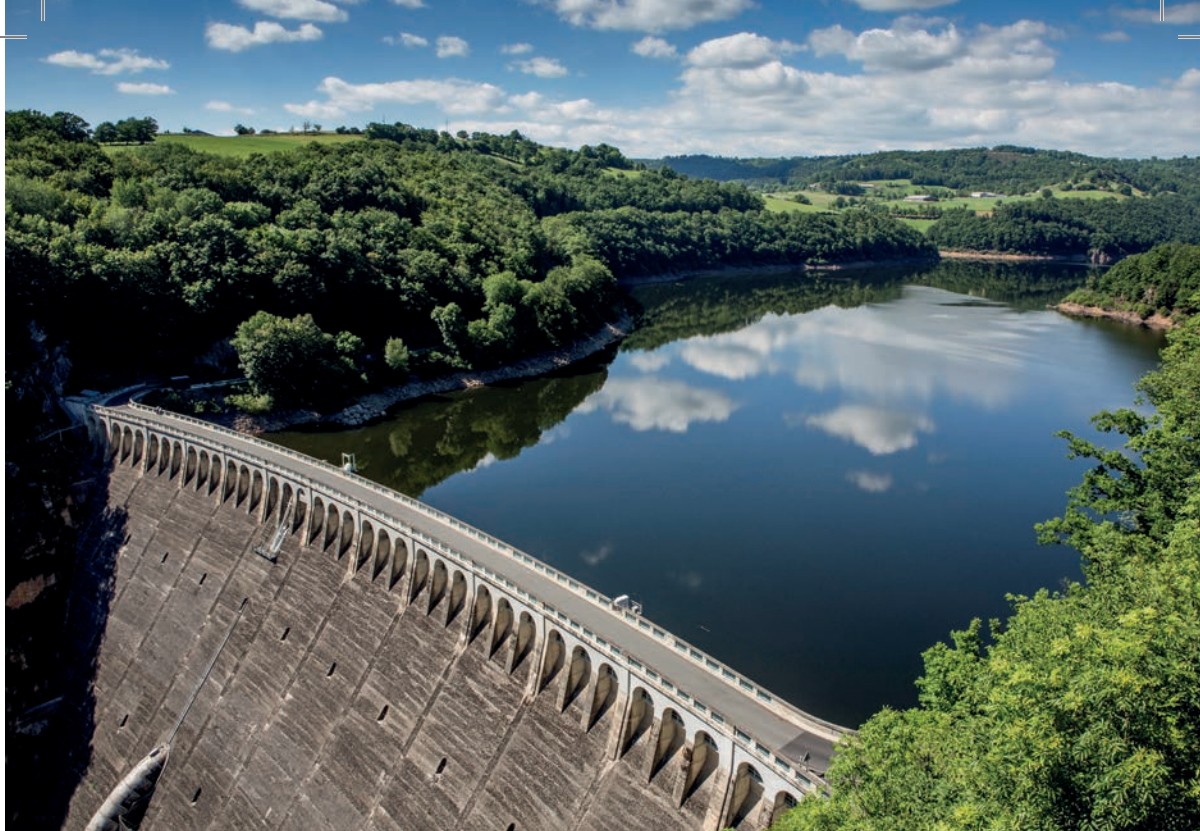
↑ Barrage de Sarrans © EDF-Pierre Soissons
